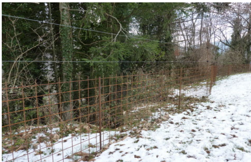
Recinzione mista realizzata con reti da edilizia (altezza 1 metro) e tondino di ferro da 16mm, con due cavi elettrici sovrastanti (Az. Agricola Ferrari Elide).
