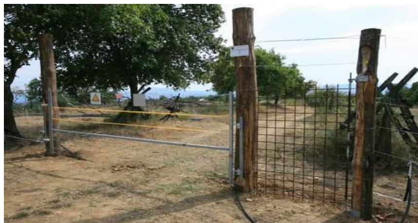
Un cancello elettrificato con a fianco un piccolo ed efficace cancello artigianale realizzato con rete elettrosaldata da edilizia (Az. Agricola i Pianacci, Scarperia)
